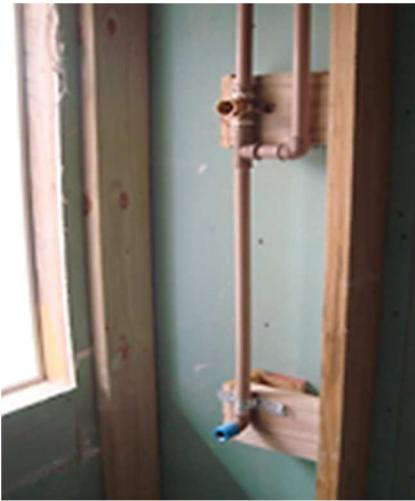
Figura 22 – Detalhe do posicionamento das tubulações hidráulicas
