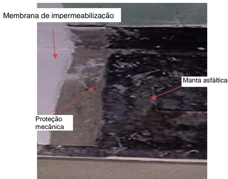
Figura 15 – Detalhe das camadas de impermeabilização
