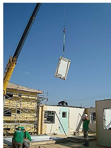
Figura 24 – Movimentação e montagem das paredes
