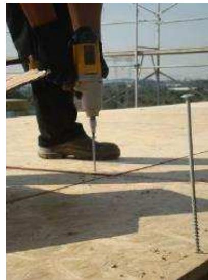
Figura 26 – Fixação do quadro estrutural de entrepiso na travessa superior da parede
