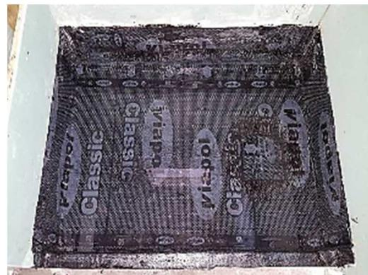
Figura 14 – Aplicação de manta asfáltica – região do box
