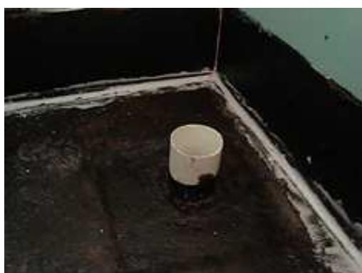
Figura 13 – Aplicação de pintura betuminosa e mastique de poliuretano (quebra de canto) – região do box
