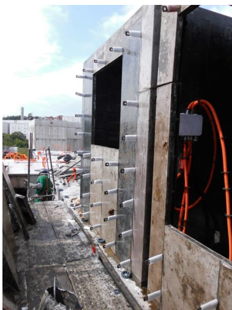
Figura 7 – Montagem das fôrmas e colocação das gravatas
