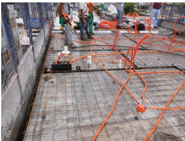
Figura 11 – Montagem da armadura da laje
