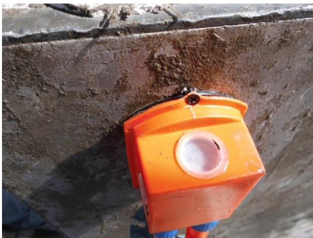
Figura 9 – Caixa elétrica fixada à fôrma com parafuso
