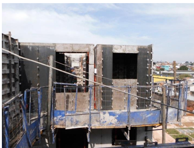
Figura 1 – Montagem das fôrmas das paredes
