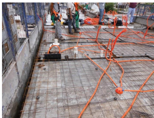
Figura 2 – Montagem das fôrmas e armadura das lajes
