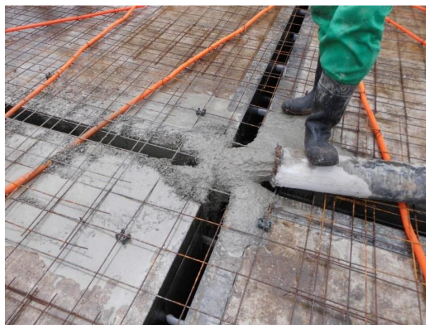
Figura 12 – Concretagem das paredes
