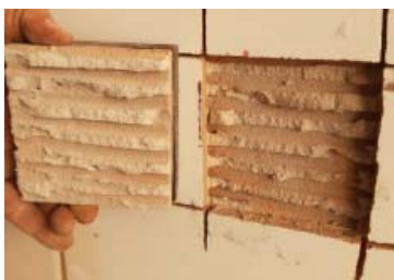
Corte seccionando a argamassa colante
