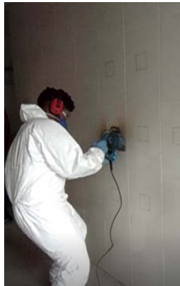
a) Demarcação e corte dos corpos de prova
