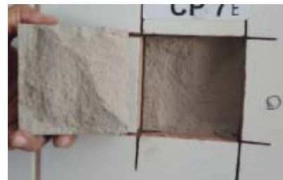
Corte seccionando o emboço
