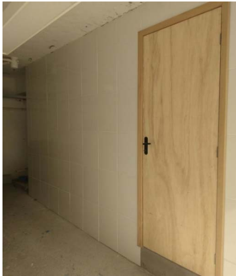
Face com revestimento
