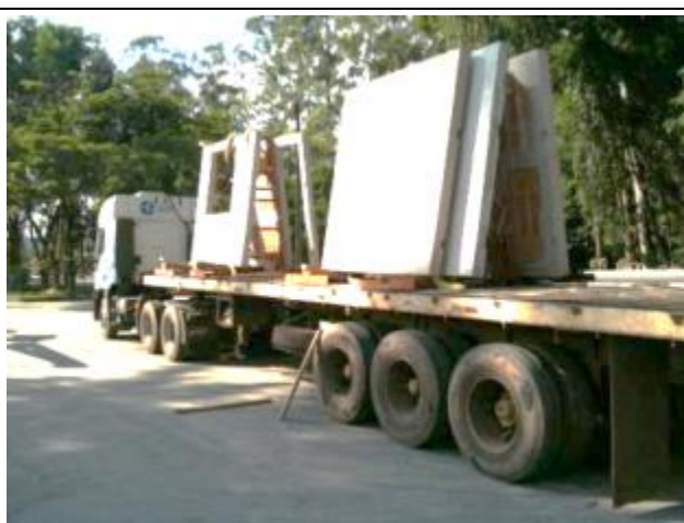
Figura 18 – Detalhe dos cavaletes para transporte dos painéis
