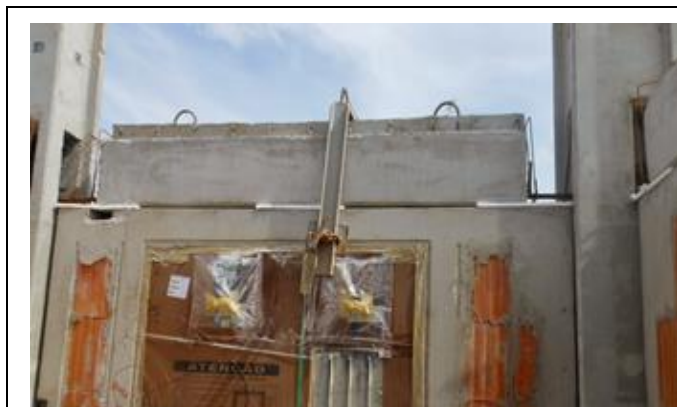
Figura 31 – Montagem da viga sobre as placas de EPS
