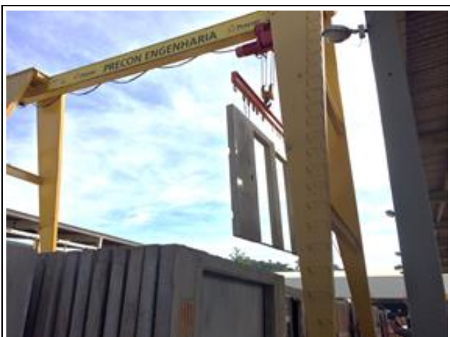
Figura 17 – Movimentação dos painéis para transporte
