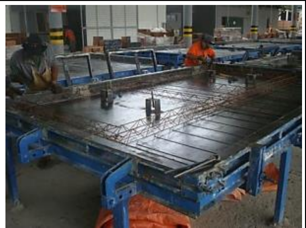
Figura 8 – Distribuição da armadura das nervuras
