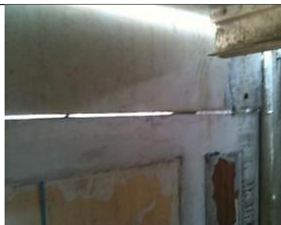
Figura 34 – Vista do vão entre a viga e o painel após a montagem
