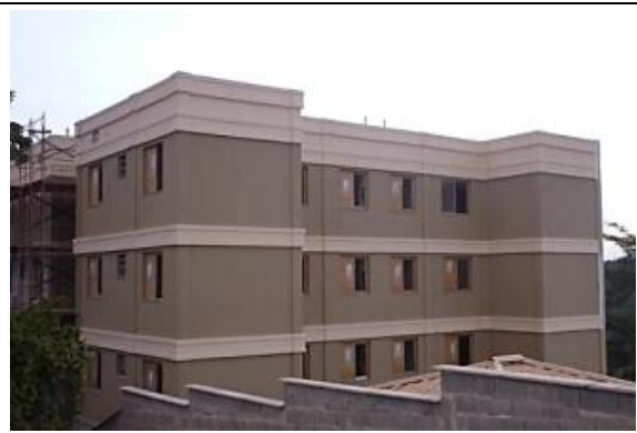
Figura 26 – Aplicação de pintura acrílica texturizada na fachada
