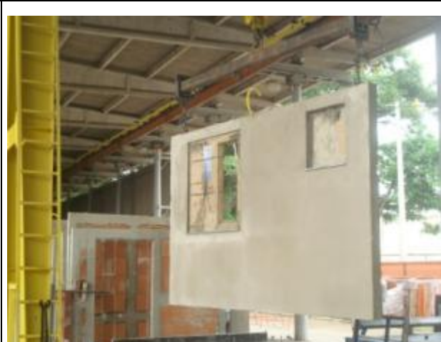
Figura 16 - Estocagem dos painéis para inspeção
