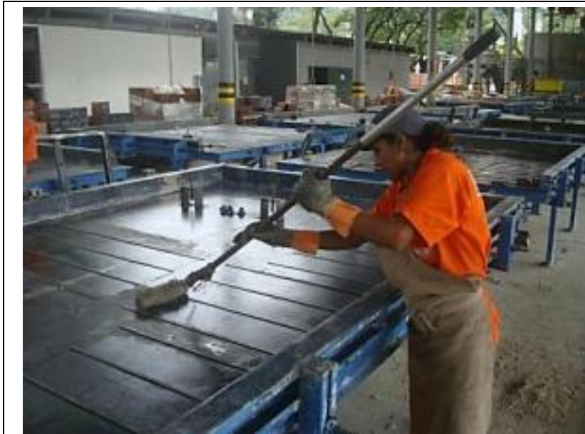
Figura 7 – Aplicação de desmoldante na fôrma
