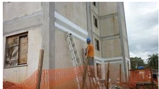
Figura 24 - Membrana acrílica sobre a tela de poliéster
