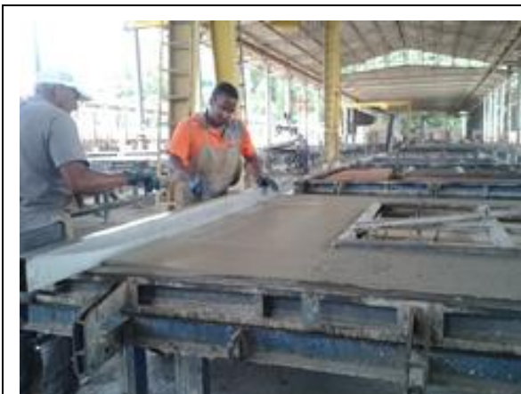
Figura 13 – Regularização com régua metálica
