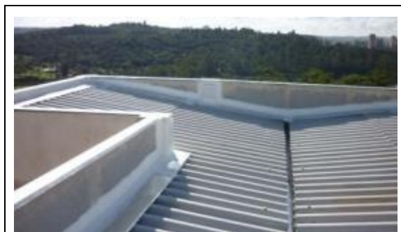
Figura 36 – Impermeabilização na interface dos rufos do telhado
