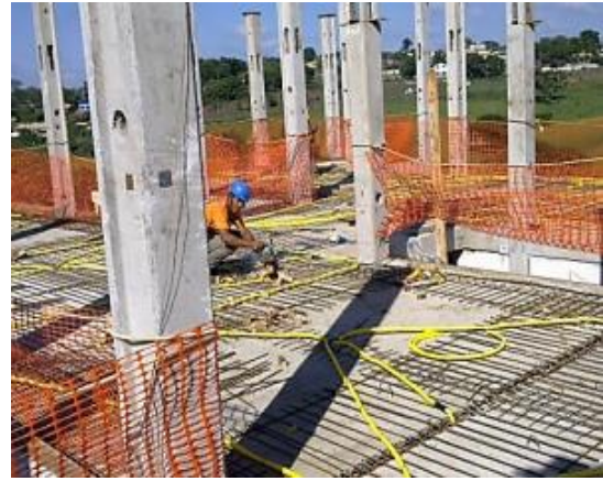
Figura 22 – Distribuição da armadura negativa e eletrodutos
