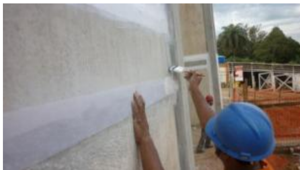
Figura 23 – Aplicação da tela de poliéster
