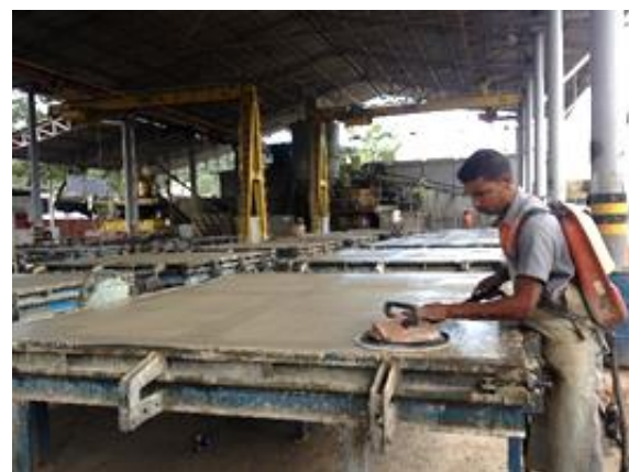
Figura 14 - Acabamento na face superior do painel
