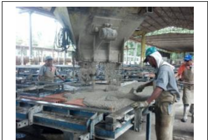
Figura 12 – Aplicação do concreto auto-adensável
