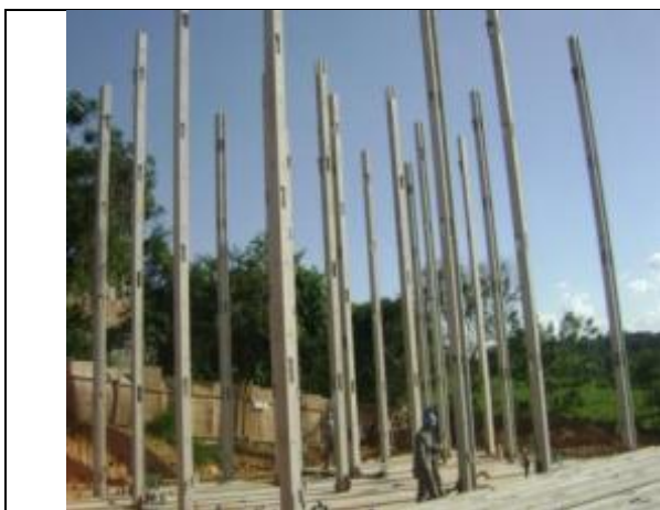
Figura 19 – Montagem dos pilares na fundação
