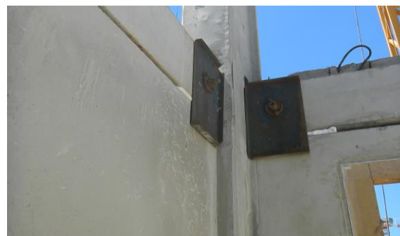
Figura 32 – Solidarização das vigas ao pilar
