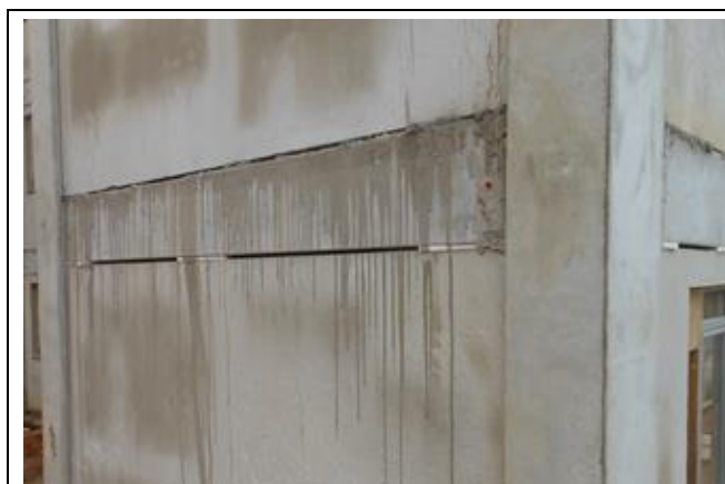
Figura 33 – Montagem final da viga, previamente ao preenchimento do vão
