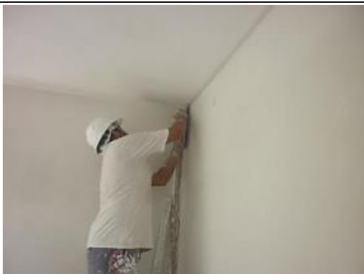
Figura 25 - Aplicação de gesso liso na face interna do painel
