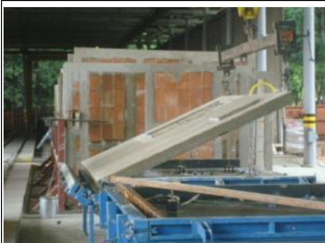
Figura 15 - Desenforma dos painéis
