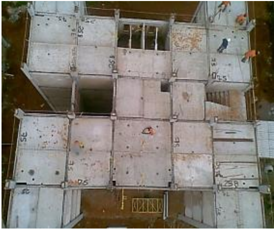
Figura 21 – Montagem das pré-lajes sobre escoramento metálico
