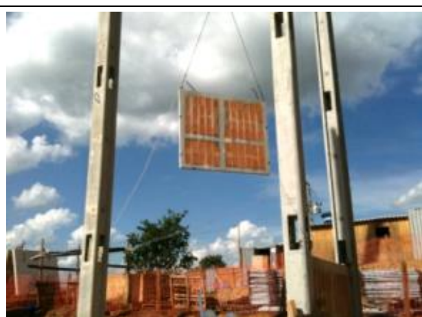
Figura 20 – Montagem dos painéis
