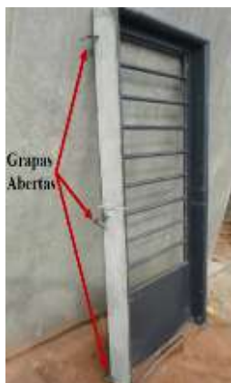
Figura 31 – Marco de porta de aço preenchido com argamassa e grapas para fixação no painel de parede.
