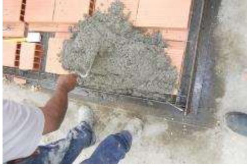
Figura 10 – Lançamento da segunda camada de concreto.
