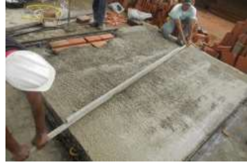
Figura 11 – Sarrafeamento da segunda camada de concreto.
