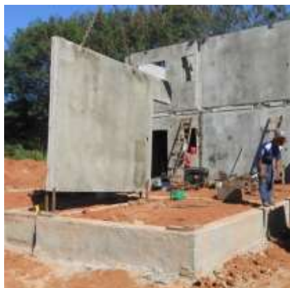
Figura 17 – Assentamento do painel de parede.
