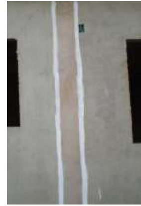
Figura 29 – Aplicação de emulsão acrílica na região de juntas entre painéis.
