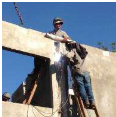
Figura 20 – Soldagem entre painéis.
