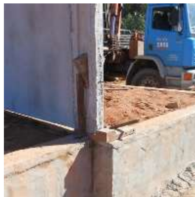
Figura 18 – Travamento do painel com auxílio de cunha de madeira.
