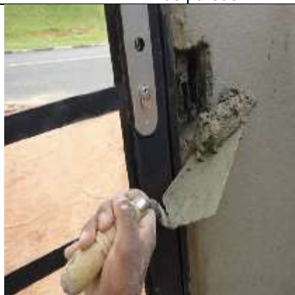
Figura 33 – Assentamento da grapa no rebaixo do painel com argamassa.
