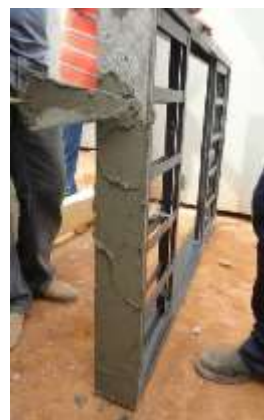
Figura 32 – Aplicação de argamassa colante no marco da janela de aço.
