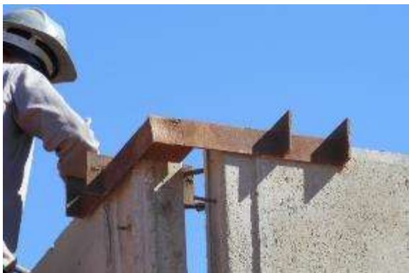
Figura 19 – Trava metálica superior.
