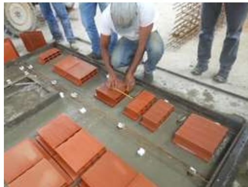
Figura 08 – Posicionamento das lajotas cerâmicas.
