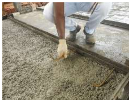
Figura 06 – Posicionamento das barras de soldagem.
