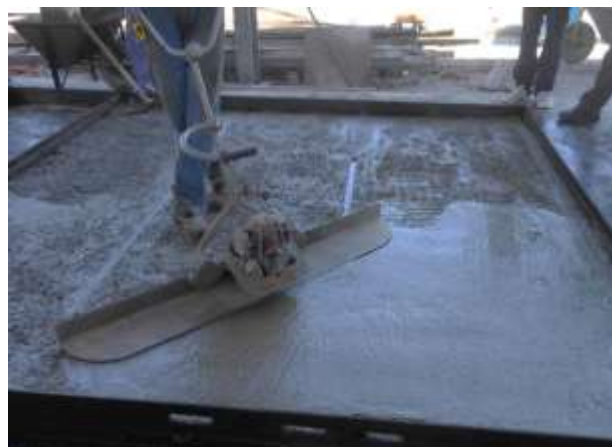
Figura 04 – Adensamento da primeira camada de concreto com régua vibratória.
