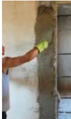
Figura 28 – Acabamento em camada de argamassa de revestimento.
