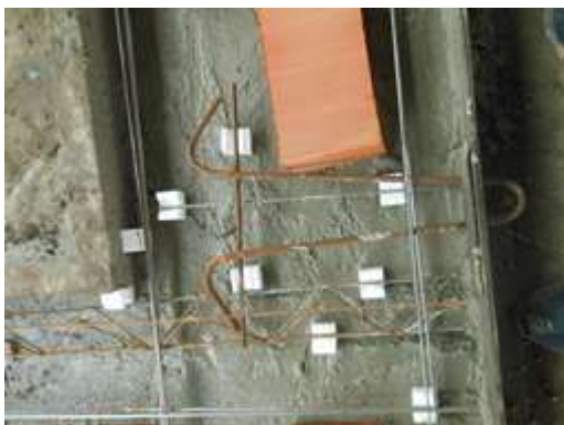
Figura 07 – Posicionamento das alças de içamento.
