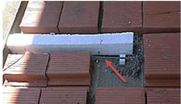
Figura 13 – Nicho com reforço para instalação de tubulação hidráulica (painel de parede hidráulica).
