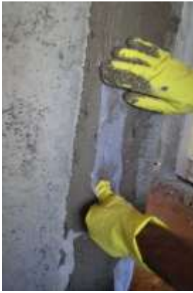
Figura 27 – Fixação da tela de poliéster sobre argamassa colante tipo ACI.
