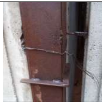
Figura 26 – Fôrma para grauteamento entre painéis.
