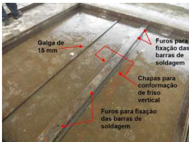
Figura 03 – Posicionamento da galga e do conjunto formado por chapas metálicas retas e chapas metálicas dobradas e chapas metálicas para conformação dos frisos verticais.
