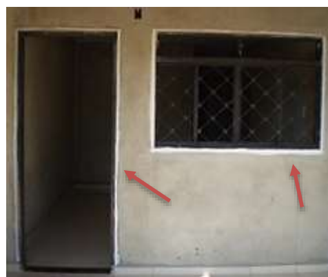
Figura 36 – Detalhe da emulsão acrílica no perímetro das esquadrias
