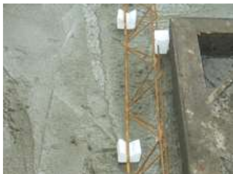
Figura 05 – Posicionamento das treliças metálicas e barras de aço retas (vergas e contra vergas).
