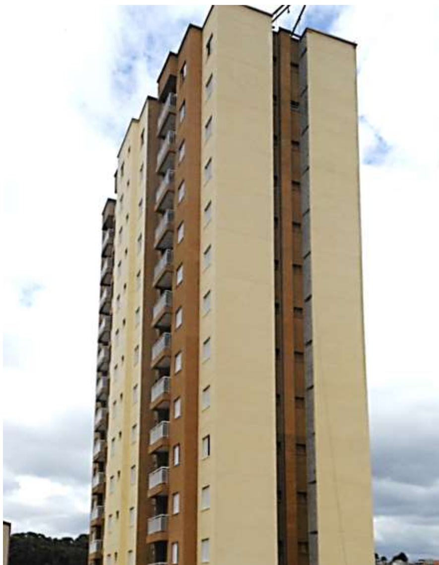
Figura 1 – Fachada com revestimento “Top Revest H”
