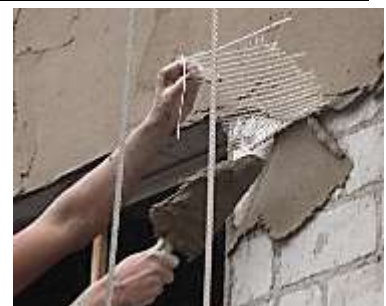
Figura 11 - Ilustração da aplicação da tela de fibra de vidro nas interfaces com elemento de concreto (laje) e nos vértices das aberturas.
