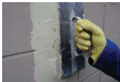
Figura 6 – Aplicação inicial da argamassa (imprimação).
