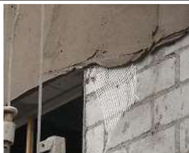
Figura 11 - Ilustração da aplicação da tela de fibra de vidro nas interfaces com elemento de concreto (laje) e nos vértices das aberturas.
