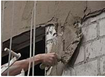
Figura 12 - Aplicação da tela de reforço.
