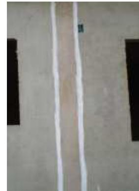
Figura 30 – Aplicação de emulsão acrílica na região de juntas entre painéis.
