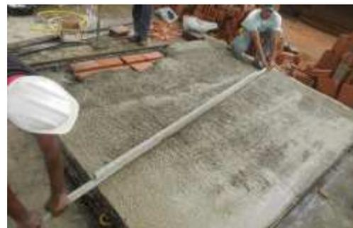
Figura 12 – Sarrafeamento da segunda camada de concreto.
