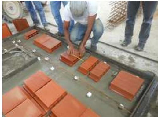
Figura 09 – Posicionamento das lajotas cerâmicas.
