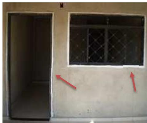
Figura 37 – Detalhe da emulsão acrílica no perímetro das esquadrias
