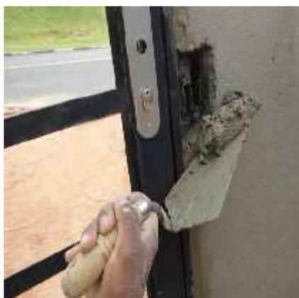
Figura 34 – Assentamento da grapa no rebaixo do painel com argamassa.
