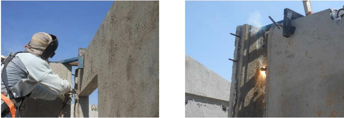
Figura 21 – Soldagem entre painéis.
