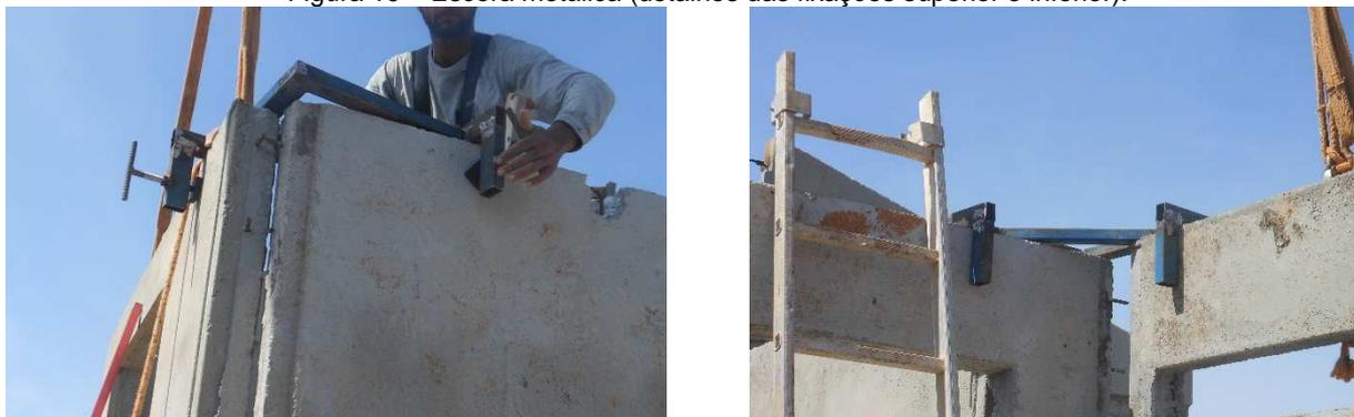
Figura 20 – Dispositivos metálicos de fixação entre painéis.
