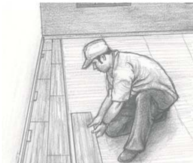
Figura 3 – Instalação do piso laminado.
